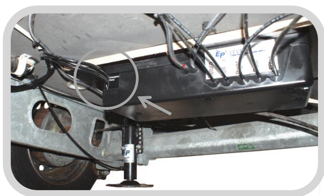
Kunststof pompbehuizing met hierin de aansluiting(en) naar de noodbediening-handpomp.
